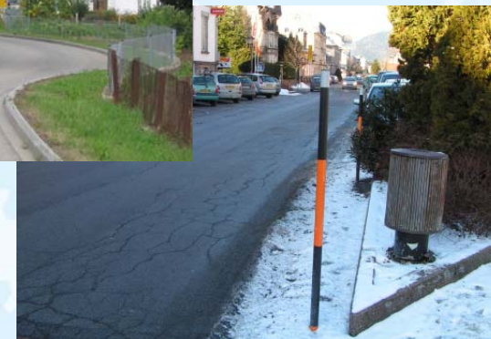
Piquets délimitant l'emprise de chaussée
