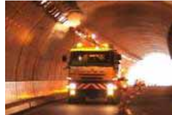
Fig.3-Nettoyage à grande vitesse par cavitation 50km/h
