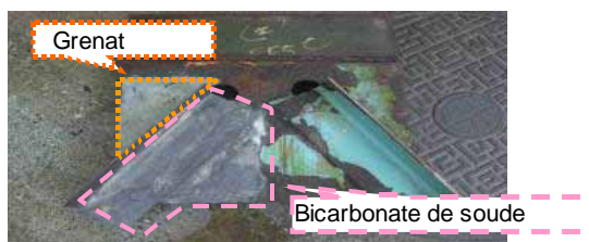
Fig. 18-Décapage au moyen du jet de cavitation contenant un mélange eau/produit abrasif
