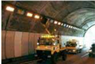
Fig. 2-Nettoyage effectué jusqu'à présent au moyen de brosses rotatives 1 – 2 km/h
