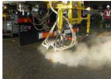
Fig. 23-Mouvement de va-et-vient horizontal des buses avec projection de jets par cavitation
